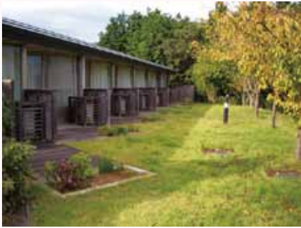
ベッドのままテラスに出られる緩和ケア病棟
